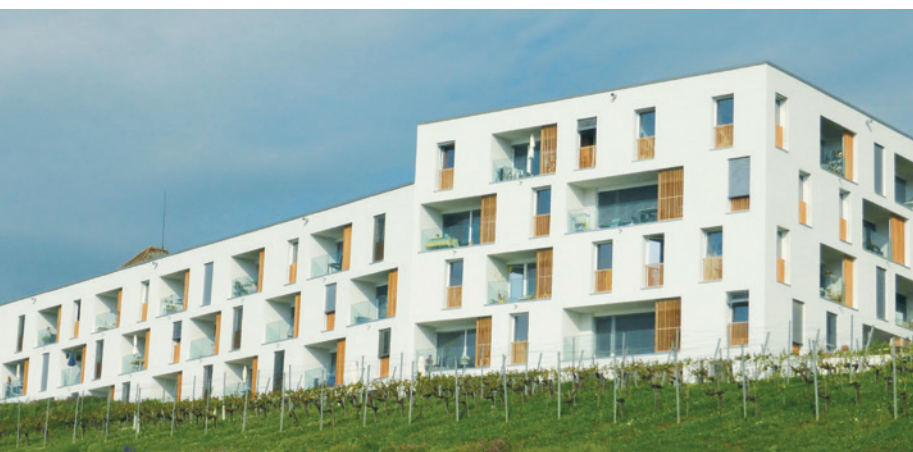
Das viergeschossige Gebäude steht im Rebberg und blickt auf den Neuenburgersee.
