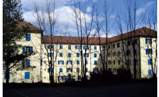
Liegenschaft Tivoli der FPHL: Erstellt 1933, saniert 1999, 60 Wohnungen. EGW-Quoten 2.6 Mio. Franken.
