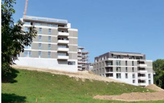
Quartier Maillefer de la SCHL: 233 logements en construction. Parts CCL de 20.5 mio. fr.
