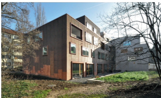
Neubau der Wohngenossenschaft Hegenheimerstrasse Basel, 2011
