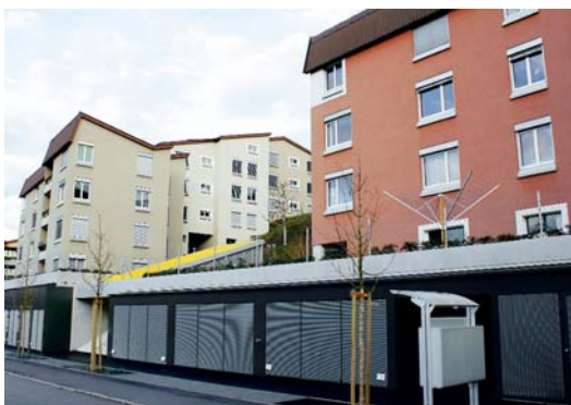
Quartier Hochhüsliweid de la SBL datant de 1967: un assainissement intérieur, assorti du réaménagement du parking et des alentours, vient de s'achever.
